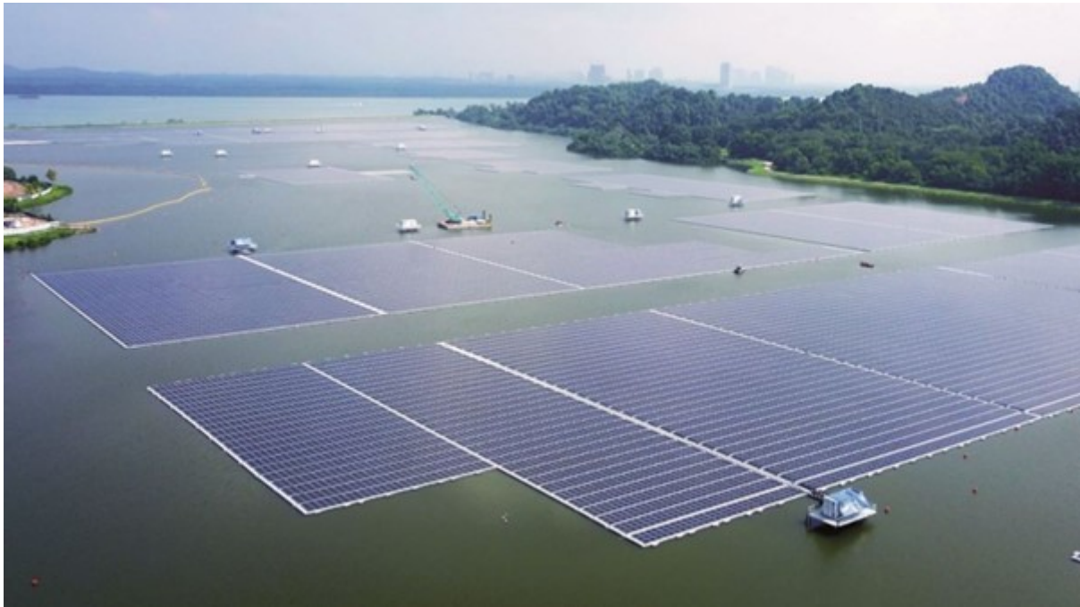
Afbeelding 3: 60 MW drijvend zonnepark in het stuwmeer van Tengeh (Singapore)
